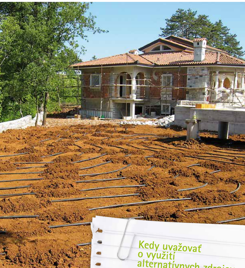
Realizácia plošného zemného kolektora
