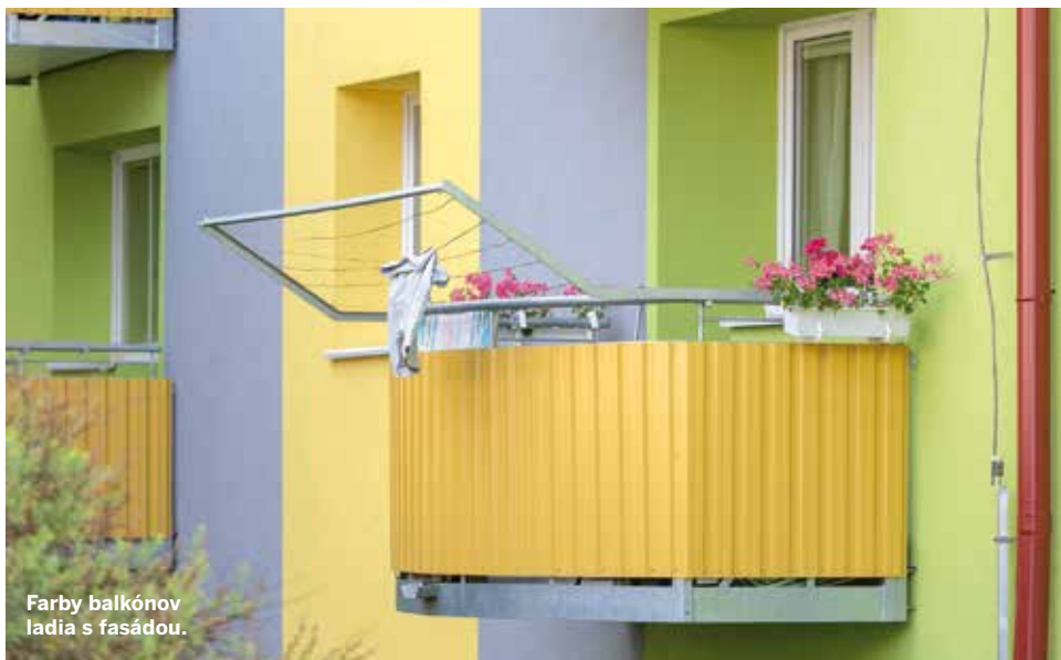
Okrem zateplenia, fasády, balkónov a elektroinštalácie obnovili aj pivnice.
